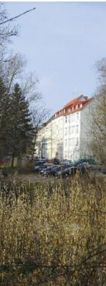
Blick auf Neue Bleicherstraße mit unsaniertem Bleichergraben
