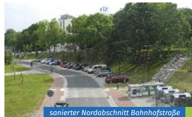
saniertes Nordabschnitt Bahnhofstraße
