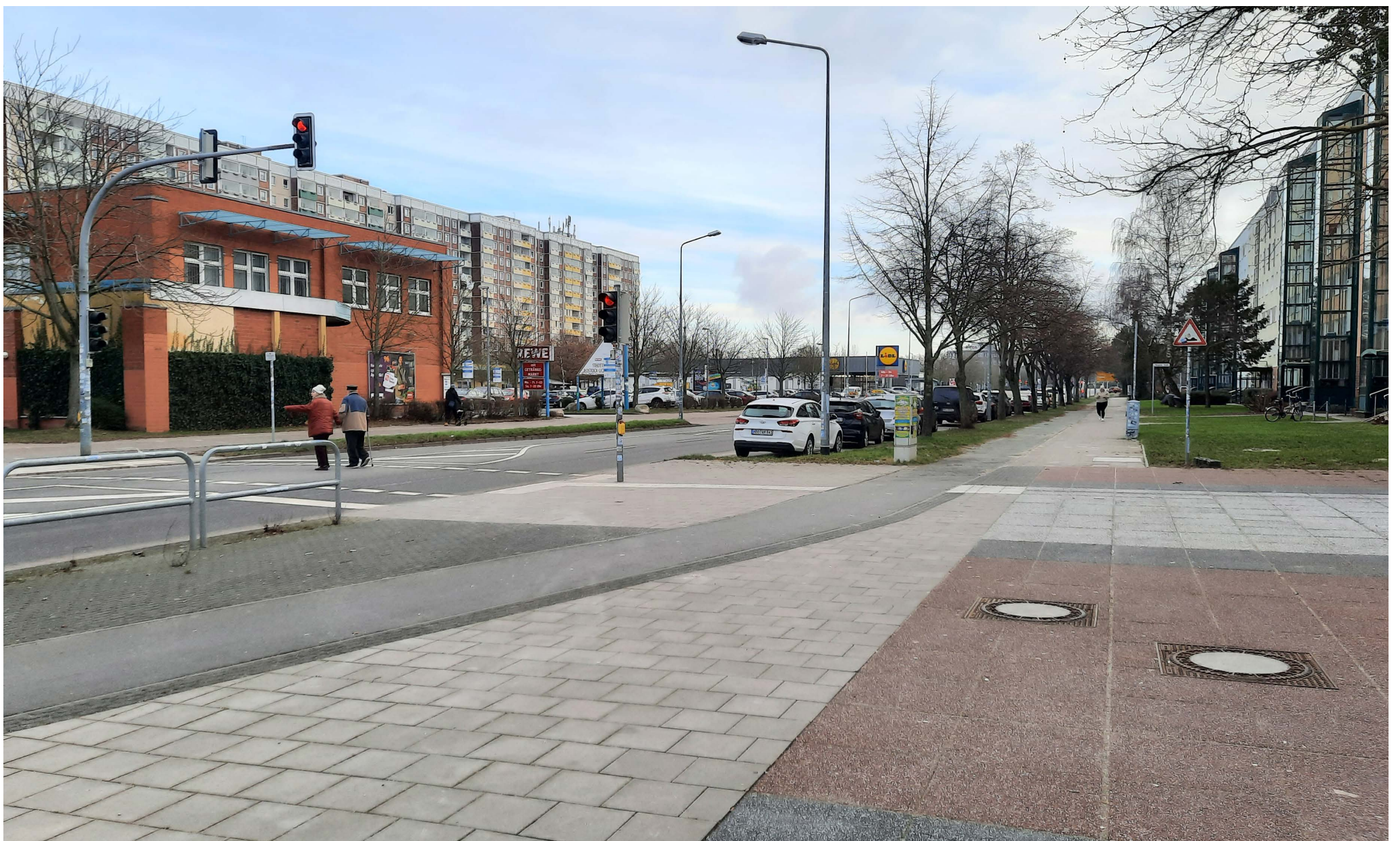
Abbildung 1: Sanierte Fußgängeranlagen in der Güstrower Straße
